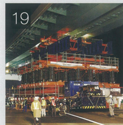
19 桁重量 1,280t・桁長 187m・桁幅 13m、 第二東名高速道路の御殿場JCTランプ橋
