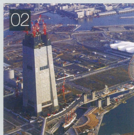
クローラクレーンによる低層棟建設及び高層棟建設の荷捌作業
