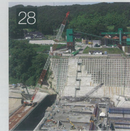
28 石川県金沢市、 犀川本流中流部のダム建設
