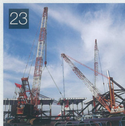
23 羽田国際空港D滑走路橋脚部 ジャケット組立一体化
