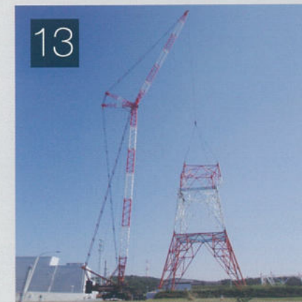
13 プラント内避雷塔（約150m）の撤去解体
