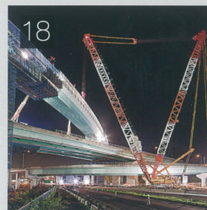
18 桁重量 240t・桁長 34.8m・桁幅 14.9m、 圏央道東金IC～茂原長南IC間
