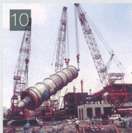
10 水切〜構内運搬したリアクターをクローラクレーンにて据付
