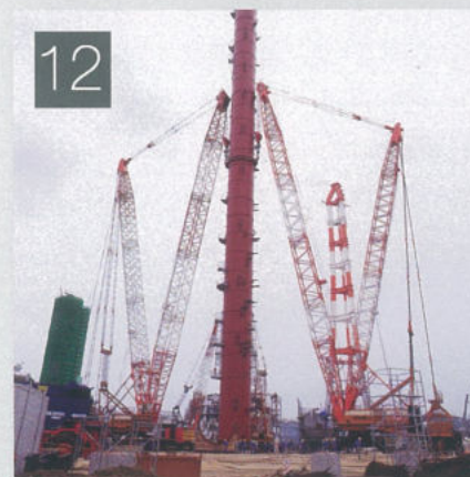
12 450t クローラクレーン（台車付仕様）2台の相吊によるリアクター据付
