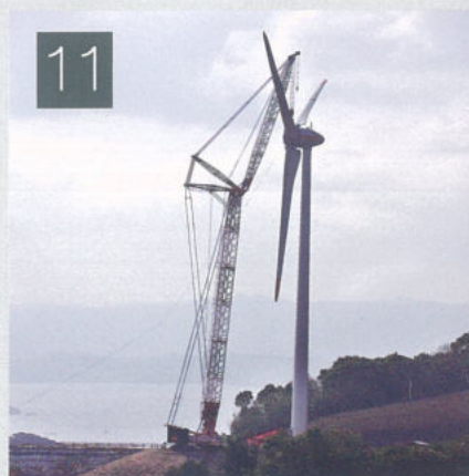
11 500t クローラクレーンによる風力発電機のブレード取付
