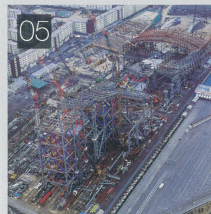
750tクローラクレーンによる屋内スキー場の鉄骨建方及び解体
