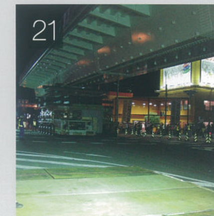
21 桁重量 280t・桁長 82m・桁幅 9m、 国道56号の河ノ瀬交差点立体交差化
