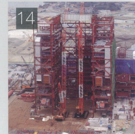
14 750t、450t クローラクレーンによる火力発電所のボイラー建屋建設
