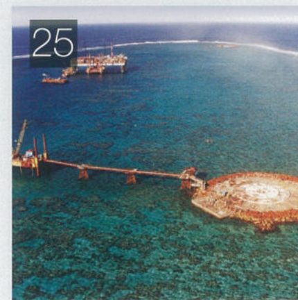
25 コンクリート護岸工事及び 消波ブロック設置
