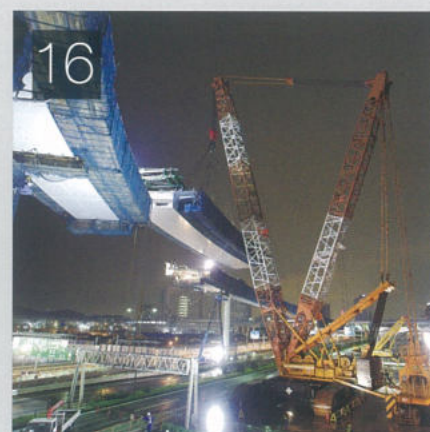
16 桁重量 253.6t・桁長 39m、 湾岸線有明JCT～辰巳JCT間
