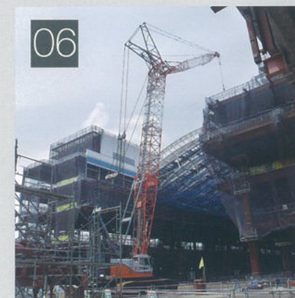
国際線供用による羽田空港の発着回数増加に伴うターミナル増築
