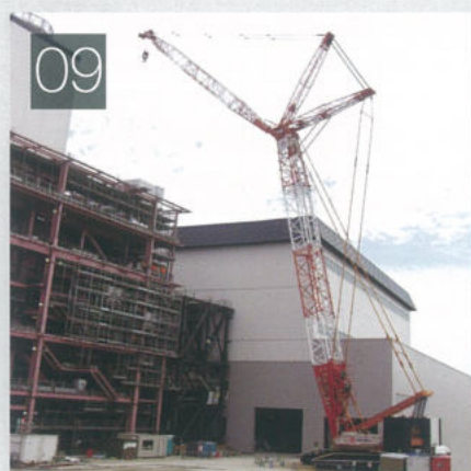
09 500t クローラクレーンによる火力発電所の建屋建設
