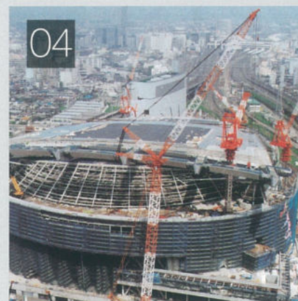
地下1階、地上7階、建築面積43,730m 2 の多目的ホール
