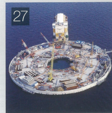
27 直径約 200m、深さ 75m、 川崎市浮島の沖合約 5km に建設された換気施設
