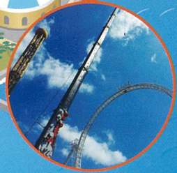
アトラクション工事
